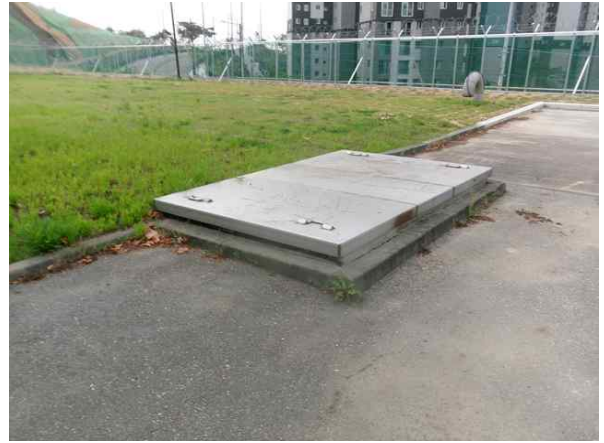
환기구 등의 덮개(장비 반입구) 현황
