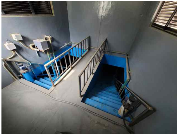
검수실 내부 전경
