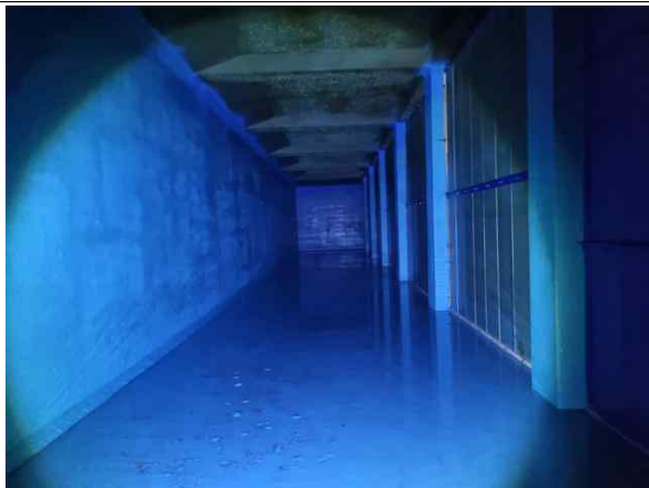
배수지 1지 내부 전경
